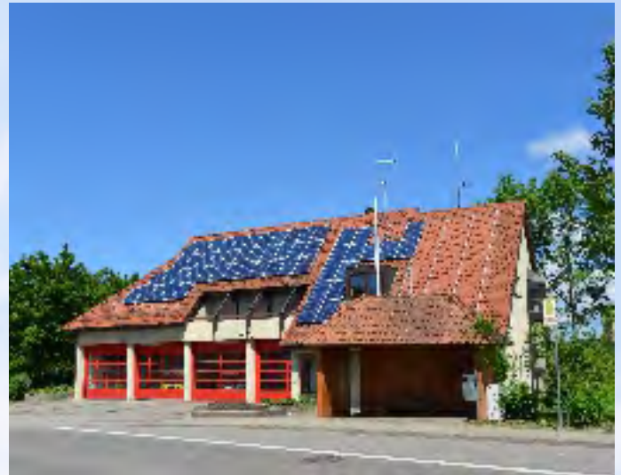
Photovoltaikanlage auf dem Dach des Feuerwehrgerätehauses in Weissach im Tal - Aichholzof
