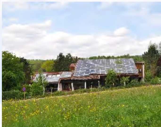
Photovoltaikanlage auf dem Dach des Kindergartens in Weissach im Tal - Oberweissach
