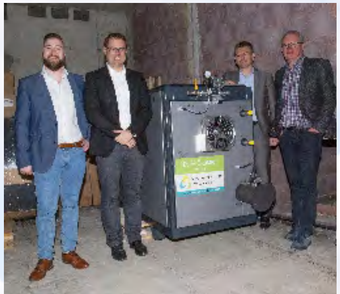
Von links: Steffen Kühner (EM Energiemanagement, Kernen i.R.), Andreas Benignus (Bauträger ASPA), Ian Schölzel (Bürgermeister Weissach im Tal) und Reinhard Knüdeler (Energiegemeinschaft Weissacher Tal eG) mit dem neuen Blockheizkraftwerk, das im Romboldareal Wärme für 87 Wohneinheiten erzeugen wird (März 2018)
